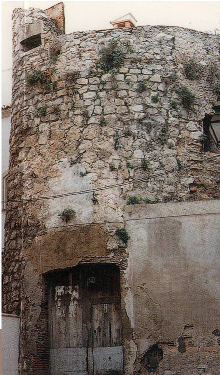
La Torre del Palau dels Centelles a Oliva, C/ La Comare. Abans de la seua restauració.
